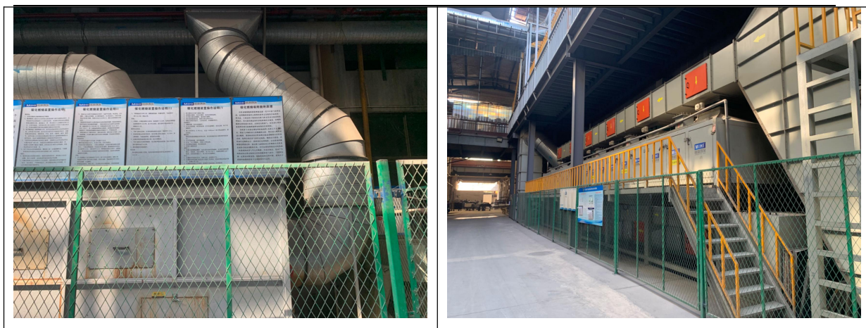
图 4-2 项目处理设施照片
